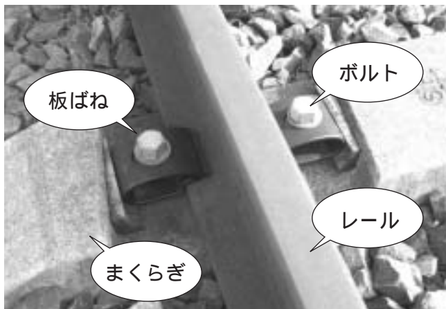
図1 板ばねタイプの締結装置
