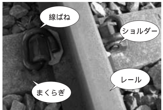
図3 線ばねタイプの締結装置
